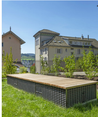
Belüftung, Rauchklappe, Sitz- und Spielbank als Einheit.
