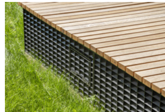
Nach dem Öffnen des Türchens im Gitterrost kann die Rauchklappe bedient werden.
